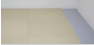
①製品を敷く 残り幅が1枚分より短くなるまで、市松貼りで敷き詰めます。
