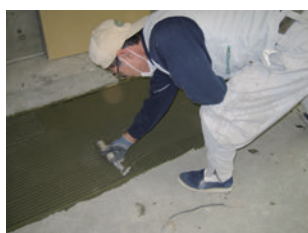
03 プライマーを塗布後、不陸の少ない、水平な下地に接着剤を塗布する。1回の塗布面積は、貼付け可能時間以内に貼り終える面積とします。貼付け可能時間は必ず接着剤の注意書きを遵守してください。
