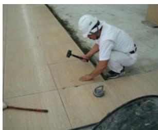
05 セメントペーストおよび敷きモルタルがタイル全裏面にすき間の無いようにしっかりと叩き押さえます。トンカチの柄やゴムハンマーを用いて目地部からセメントペーストが盛り上がるまで叩き締める。
