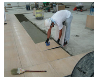
04 タイルの貼付け(目地幅3mm～サイズや商品により調整)。
