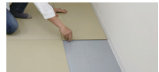
⑯製品を敷く 最後に壁側の端にはめ込みます。他の生地も同様にいきます。
