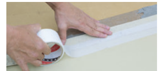
⑫巻込む生地を切らない準備 中芯のカットの前に、養生テープ等で表生地が中芯にかからないように仮止めすることをおすすめします。
