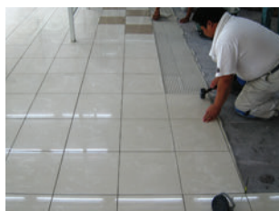
05 貼付けモルタルがやわらかいうちに叩き押しえ、モルタルがタイル裏面に広がるようにします。ゴムハンマーやヴィブラートを用います。接着剤をタイル裏面に充分付着させるには、タイルをもみ込むようにして貼り付けます。
