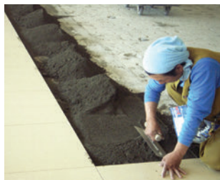
02 基準糸をはり、バサモルを敷きならす。敷きモルタル1回の敷ならし面積はタイル幅の2倍程度とします。
