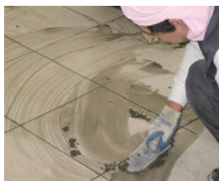
06 タイルの表面を十分に濡らし、目地セメントを施工。
