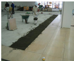
01 砂とセメントを調合する。コンクリート表面に水湿しを行った後、バサモルを平坦に敷きならす。
