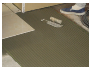
04 セメント系接着剤を塗布するときは、糸を貼り、タイルのレベルを出す。
