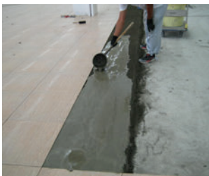
03 セメントペーストを2mm程度ムラ無く表面に流す。
